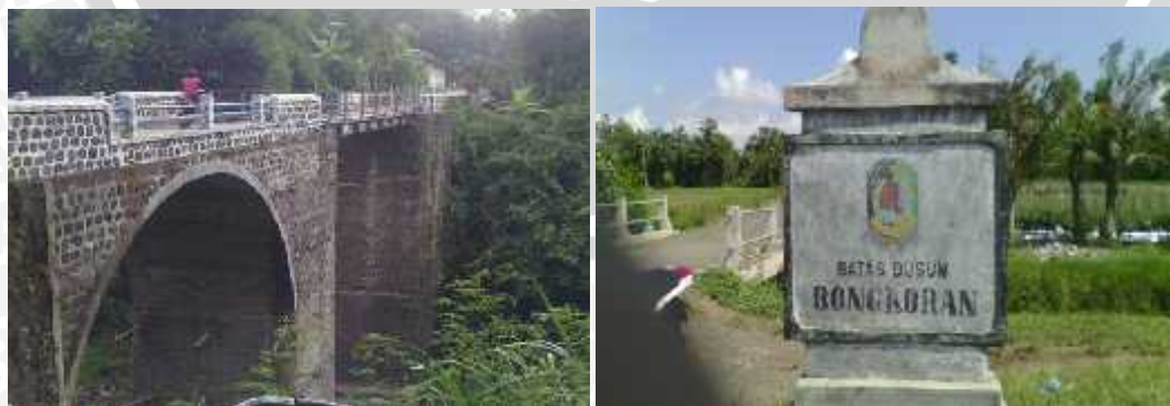
Gambar 13. Pembangunan Jembatan Sidodadi di Dusun Bongkoran
