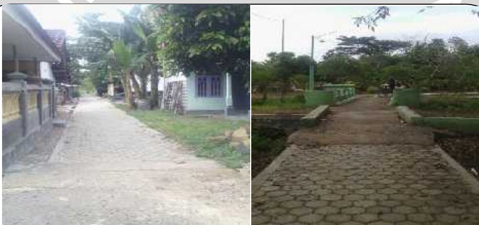
Gambar 27. Pemavingan jalan makam Dusun Sumberjo
