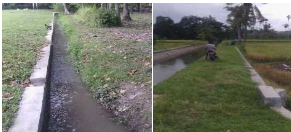
Gambar 26. Plengsengan jalan Dusun Sumberjo
