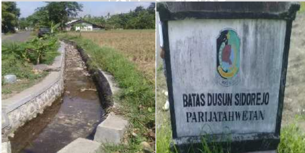
Gambar 12. Pembangunan saluran tersier pertanian di Dusun Sidorejo
