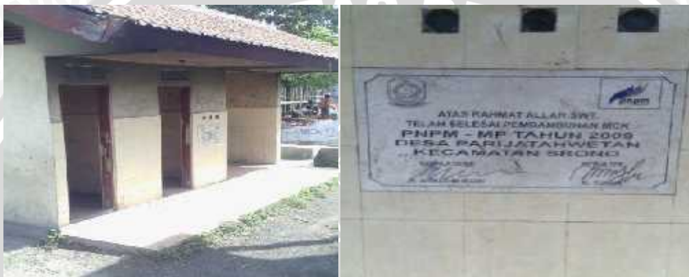
Gambar 11. Pembangunan MCK di Dusun Melik
