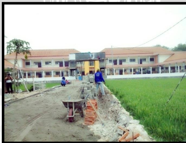
Gambar 14. Relokasi Pembangunan Gedung SDN 1 dan 2 Rahayu
