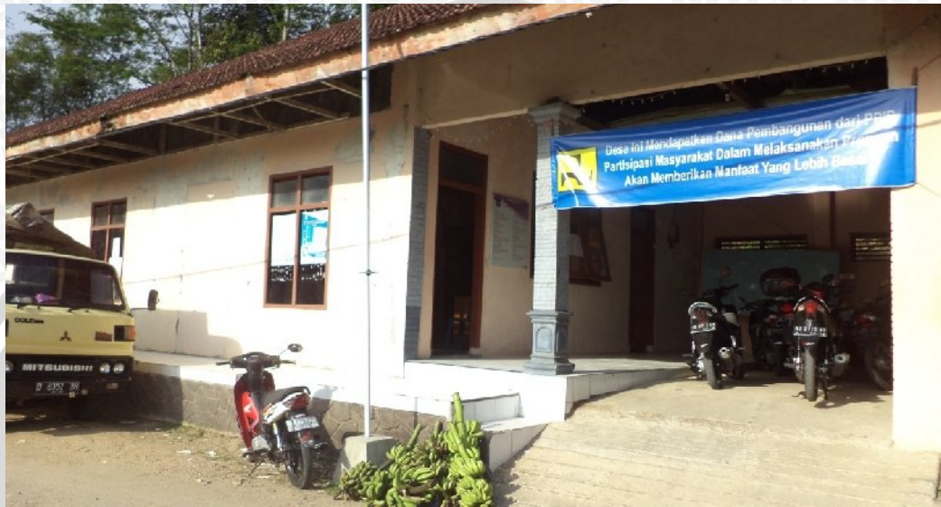
Foto Kondisi Keadaan kantor Desa Sidomulyo
