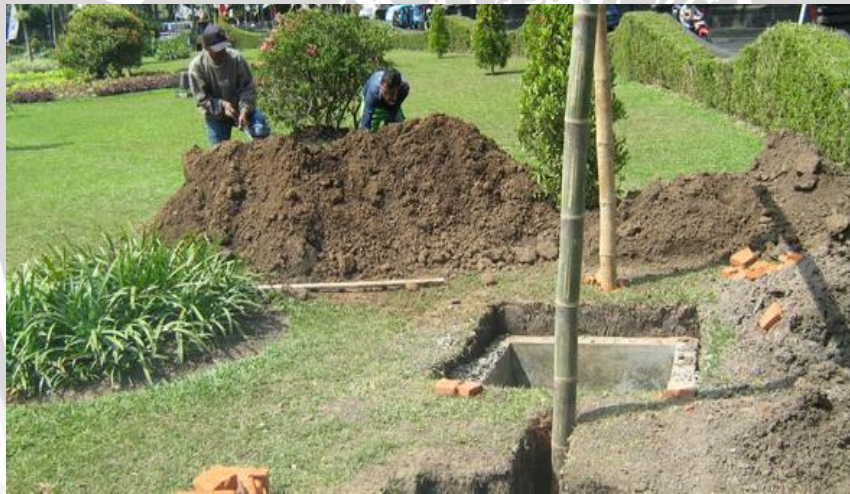
Gambar 4.5. Pembuatan Sumur Resapan
