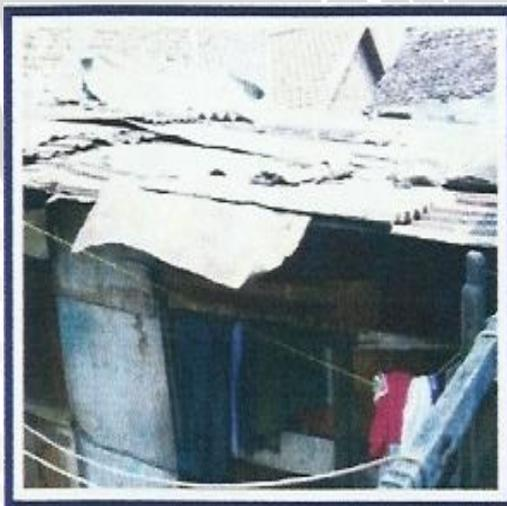
*Tampak atap rumah yang terbuat dari asbes dan tidak terawat dengan baik*
