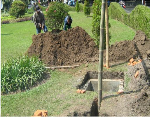
Foto: Pembuatan Sumur Resapan Air
