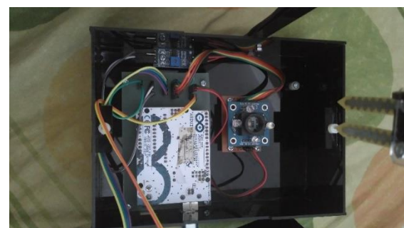
Gambar 11 Implementasi rangkaian sensor dengan PCB dan Mikrokontroler
