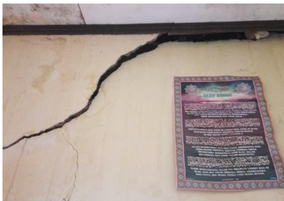
Gambar 19. Retakan Dinding Akibat Pergerakan Tanah di Cisarua (SPL 10)
