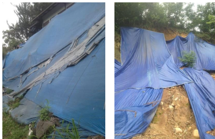
Gambar 18. Peristiwa Tanah Longsor yang Pernah Terjadi di Kecamatan Lembang (SPL 15)
