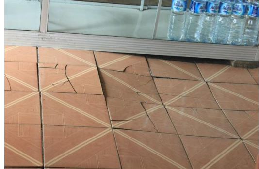
Lantai retak akibat pergerakan tanah di lokasi penelitian (SPL 7)
