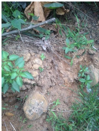
Material longsor di SPL 15
