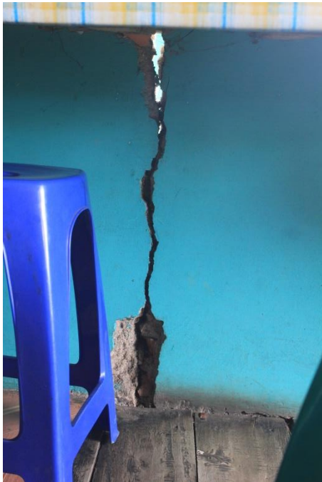
Dinding retak akibat pergerakan tanah di lokasi penelitian (SPL 10)
