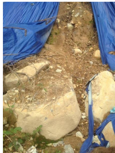
Material longsor di SPL 10
