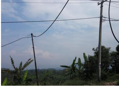
Tiang listrik miring akibat pergerakan tanah di lokasi penelitian (SPL 8)
