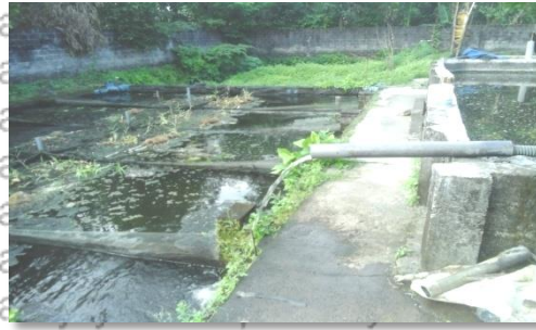
Gambar 14. Pengisian air kolam melalui pipa Sumber: Data primer, 2017
