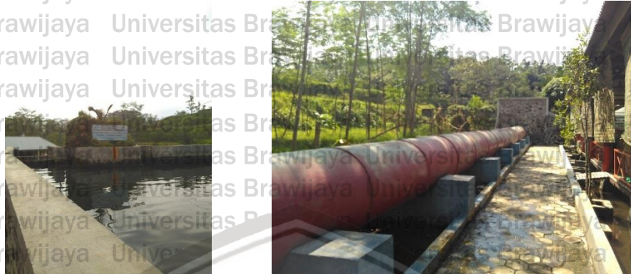
Gambar 12: Bak Penenang dan Pipa Pesat
