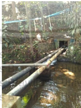
Gambar 10: Bendungan dan Intake Sumber: Dokumentasi Pribadi
