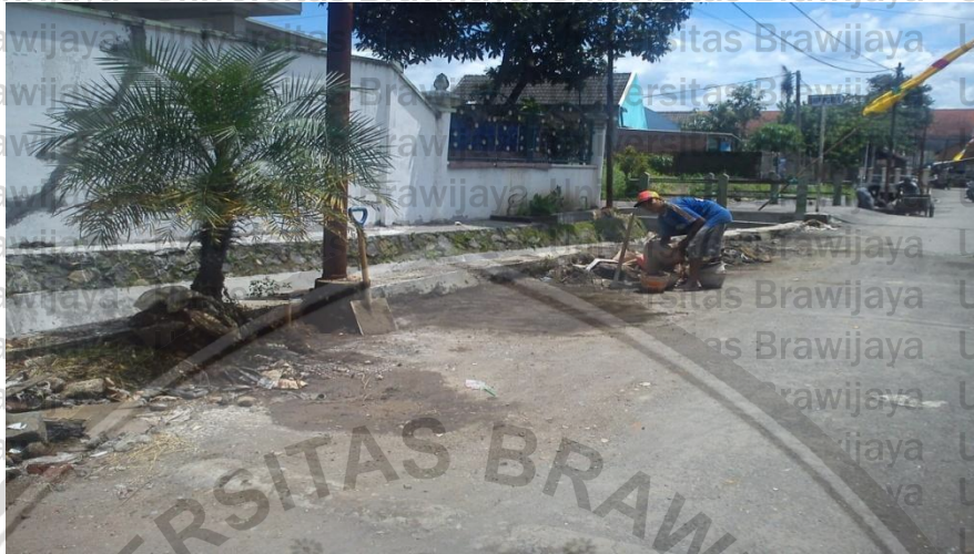
Foto pembangunan 75% drainase di kelurahan ciptomulyo
