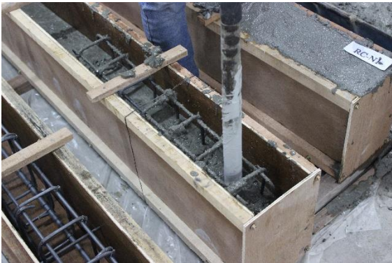
Gambar L 8.13 Pematatan beton menggunakan vibrator
