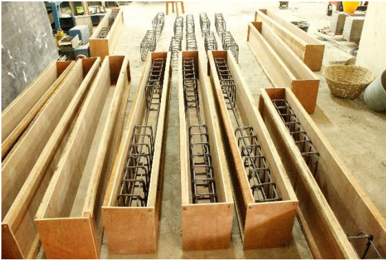
Gambar L 8.10 Bekisting balok dan tulangan
