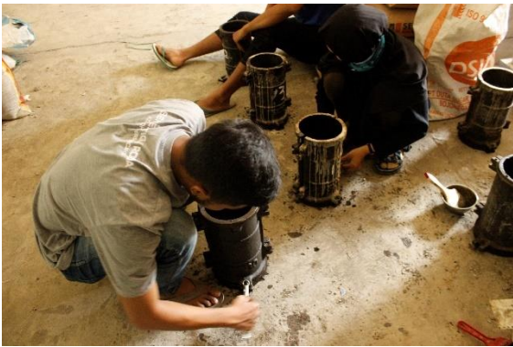
Gambar L 8.8 Pemberian minyak pada bekisting silinder
