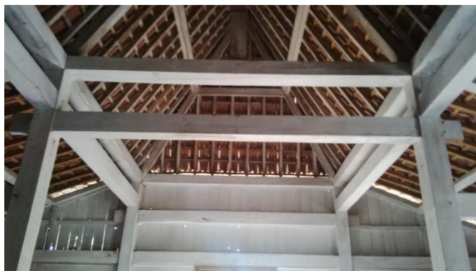
Gambar 4.36 Kayu jati sebagai elemen struktur utama
