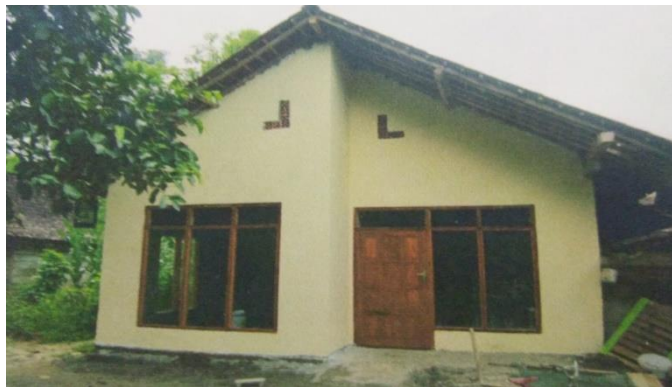
Gambar 18: Kondisi rumah Bp. Abidin 100%
