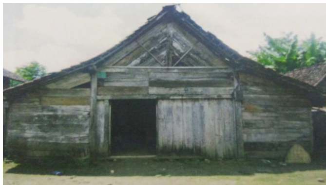
Gambar 16: Kondisi rumah Bp. Abidin 0%
