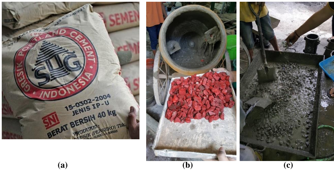
Gambar 2 (a) penggunaan semen pada pengecoran, (b) penambahan batu apung pada pengecoran, (c) proses pemberian fiber
