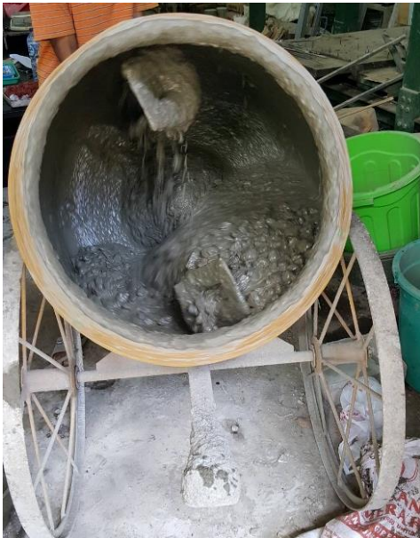
Gambar 4.2 Proses Pencampuran Material Beton Menggunakan mixer
