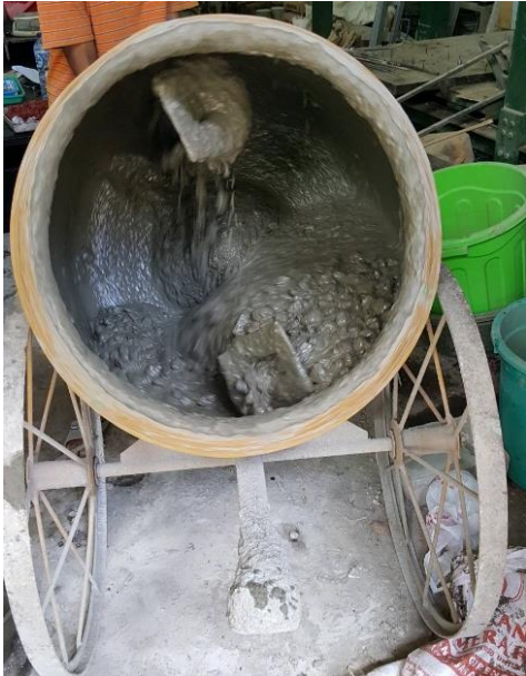
Gambar 4.2 Proses Pencampuran Material Beton Menggunakan mixer
