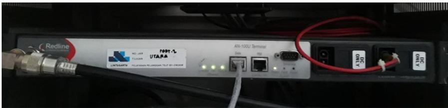
Gambar 4.4 IDU AN100U pada *Base Station (BS)*
