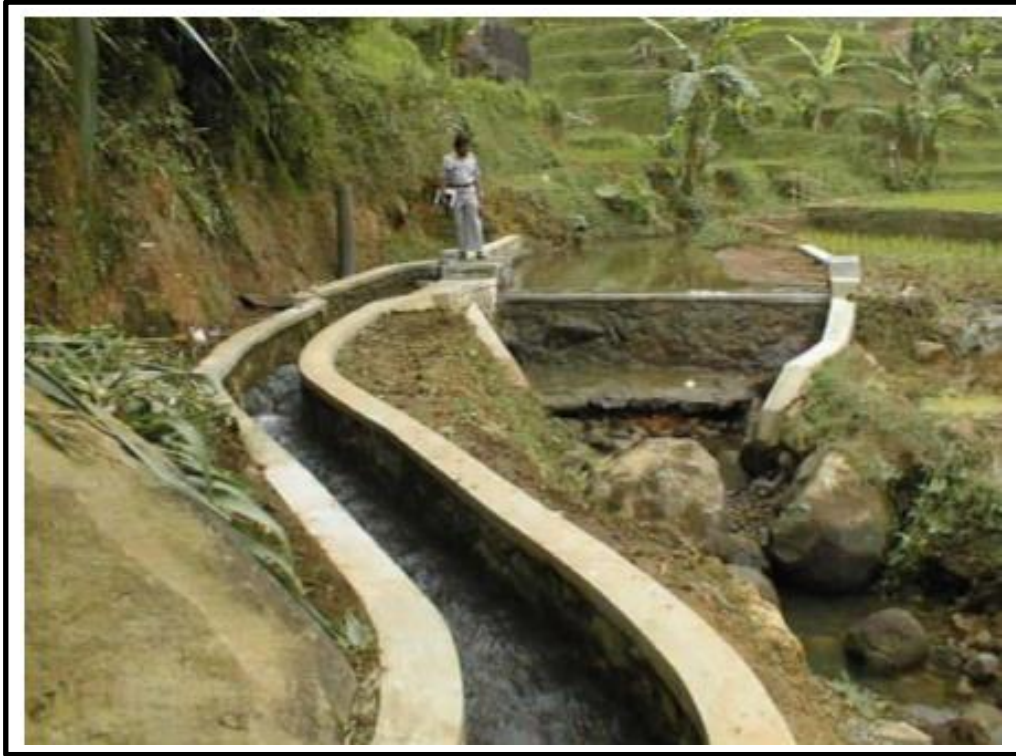
Gambar 2.35 Bangunan Pengambilan ( intake ) Sumber: JICA (2009:2-2)
