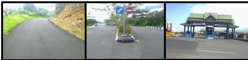
Gambar 5.29 Jalan dan Terminal di Kota Tidore Kepulauan Sumber: Foto Penulis, 2015
