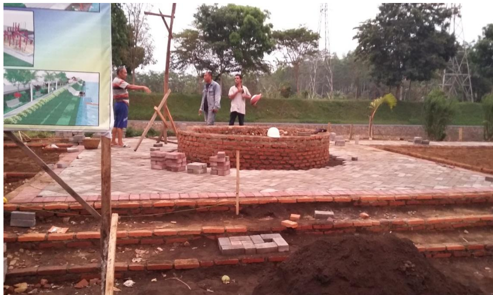
Pembangunan Tugu Taman
