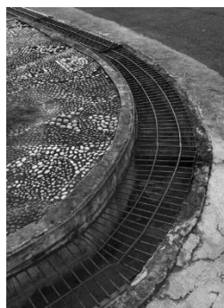
Gambar 32. Saluran drainase (selokan)
