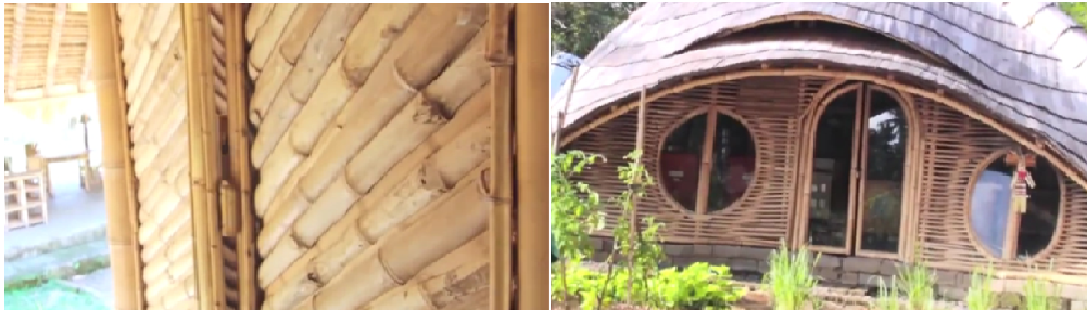
Gambar 13. Konstruksi dinding bambu pada bangunan Green School (Sumber: Indonesia Travel Series - Jalan-jalan Men Eps 9 - Bali part 2.mp4 )
