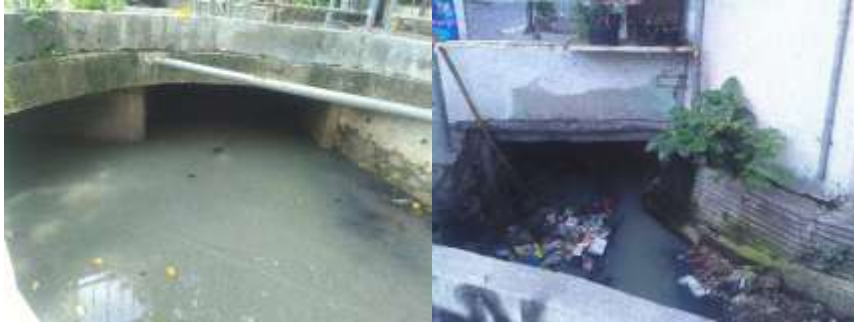
Gambar 4.8 Box culvert pada saluran Darmo Indah (1-5)
