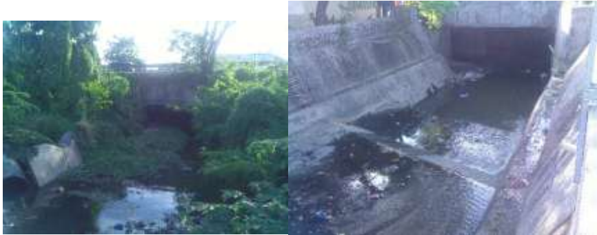
Gambar 4.9 Box Culvert pada saluran simo mulyo barat (ruas 16-17)
