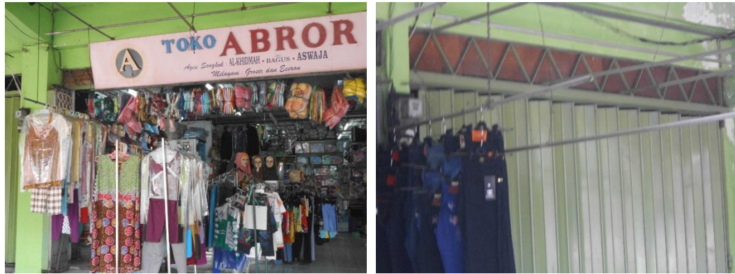
Gambar 4.23 Kondisi lubang ventilasi atas pada kios
