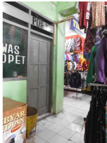
Gambar 4.13 Kondisi pos jaga di lantai 1
