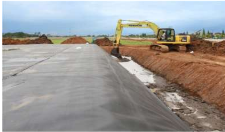
Gambar 2.14 Penggalian parit Sumber: PT. Teknindo Geosistem Unggul
