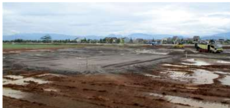
Gambar 2.10 Pelapisan tanah dengan pasir Sumber: PT. Teknindo Geosistem Unggul
