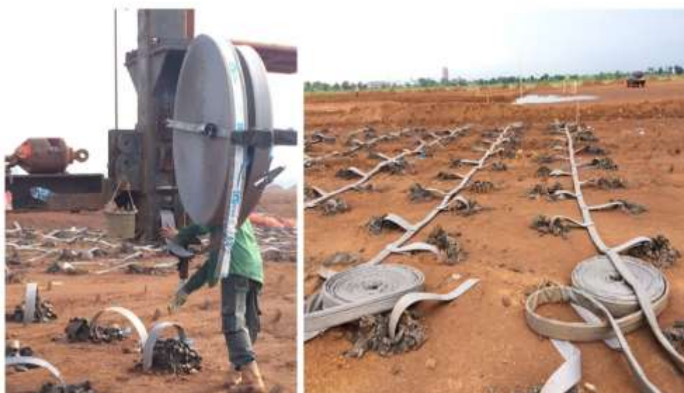
Gambar 4.3 Pemasangan Vertical drain serta horizontal drain di lapangan
