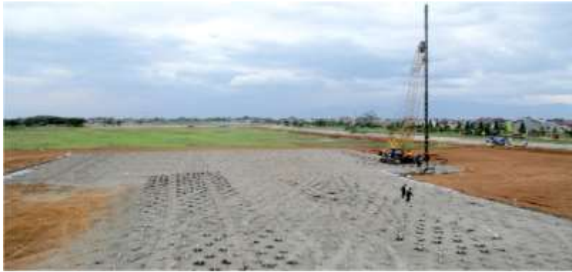
Gambar 2.11 Pemasangan PVD Sumber: PT. Teknindo Geosistem Unggul
