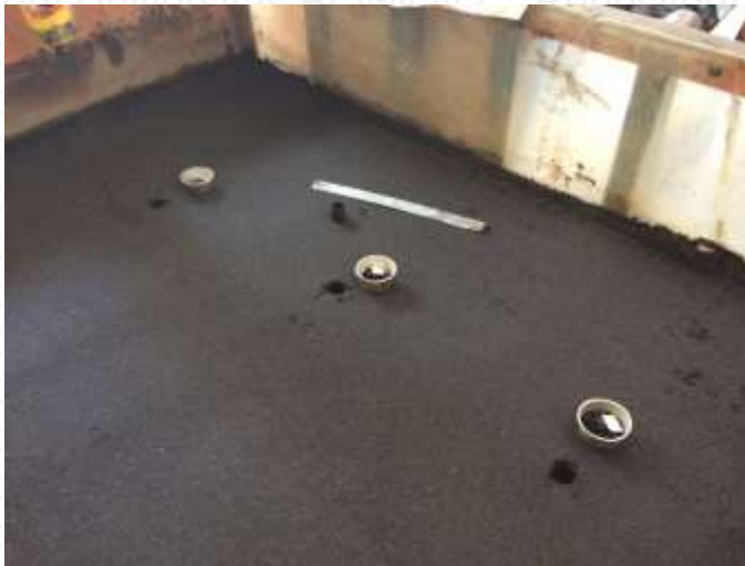
Gambar 3.5 Pengujian kadar air dan density pada sampel uji.
