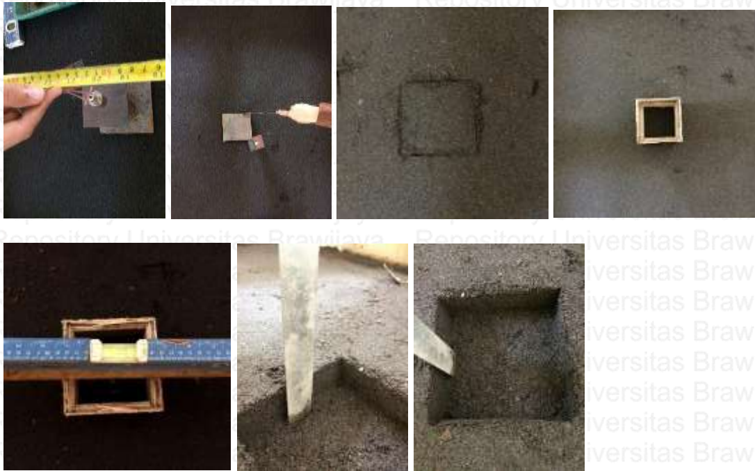
(Persiapan pemasangan pondasi pada layer teratas setelah pemadatan – Pelubangan)
