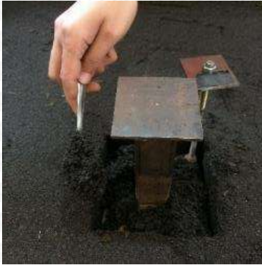
(Pemasangan Pondasi – Pengecekan Kemiringan – Overbuden )
