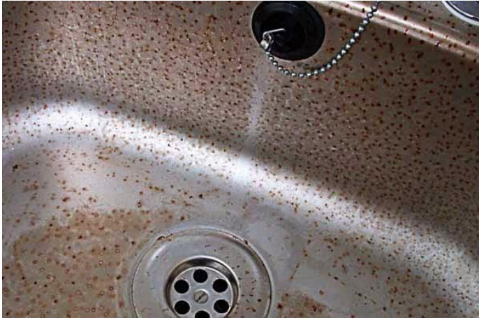
Gambar 2.4 Korosi sumuran pada wastafel Sumber: Pengantar Korosi, femiana gapsari (2017)
