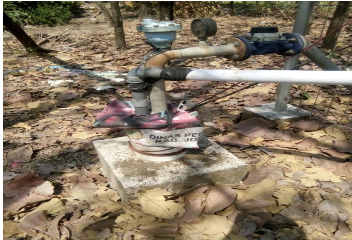
Gambar 4.16 Sumur Bor dan Saluran Pip
