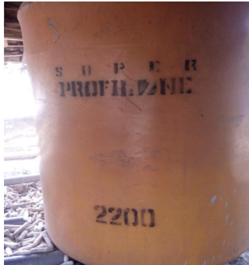
Gambar 4.11 Tandon Air Di Dusun Banyuasin
