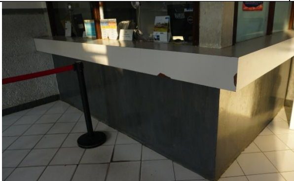
Dinding pada Loket Tiket Stasiun
