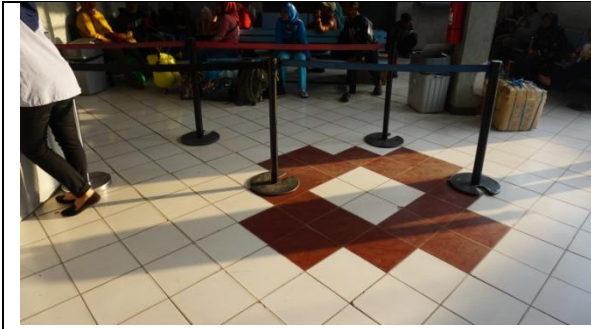
Keramik sebagai Penutup Lantai Area Masuk Utama
