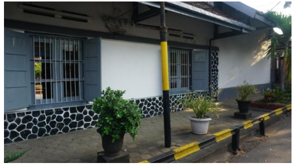
Area Teras Stasiun Sumberpucung
