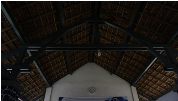
Konstruksi Kuda- Kuda pada Penutup Area Masuk Utama
