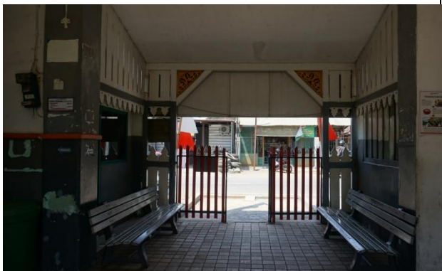
Pintu Masuk Utama Stasiun
