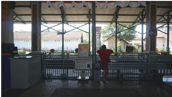
Pintu Gerbang Menuju Peron Stasiun
