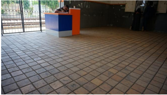
Keramik Coklat Ukuran 20x20 di Area Masuk Utama
