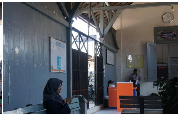
Dinding dari Papan Kayu dan Pintu Masuk
