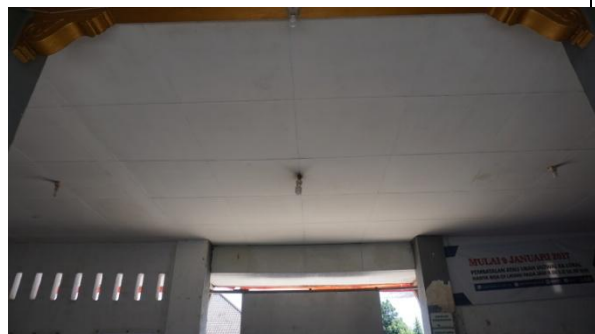
Plafon Gypsum pada Area Masuk Utama
