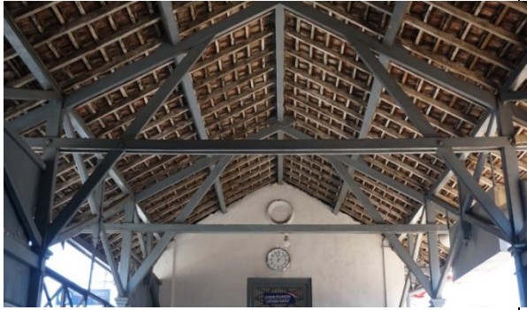
Konstruksi Kuda- Kuda sebagai Elemen Atas
