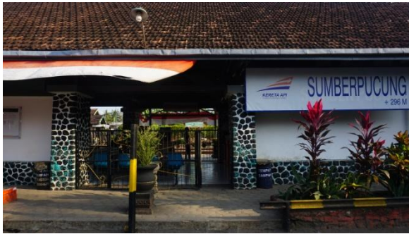
Tampak Depan Stasiun Sumberpucung
