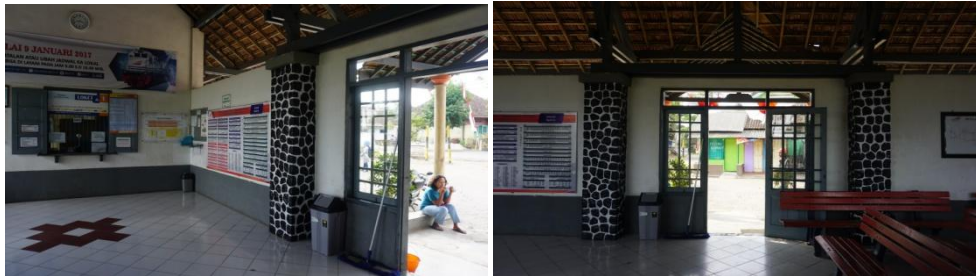
Gambar 4. 149 Kondisi Eksisting Cahaya di Area Masuk Utama Stasiun Ngebruk
