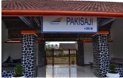
Gambar 4. 108 Kondisi Eksisting Tingkat Penutupan di Area Masuk Utama Stasiun Pakisaji
