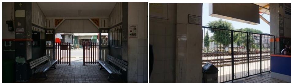
Gambar 4. 50 Kondisi Eksisting Cahaya pada Area Masuk Utama Stasiun Blimbing
