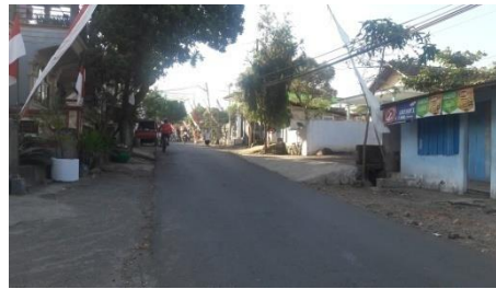
Kondisi Akses Jalan di Dusun Sumberawan
