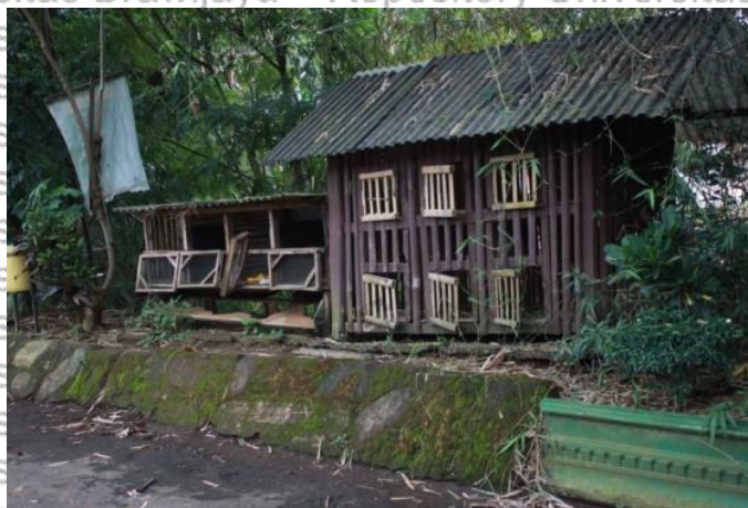
Kondisi salah satu kandang ayam yang sudah tidak difungsikan
