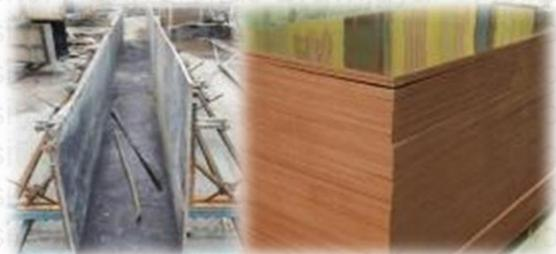
Gambar 4.54 Kayu *Phenol Film* untuk Bodeman Bekisting Balok
