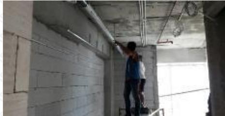
Gambar 4.120 Pemasangan Rangka Plafond
