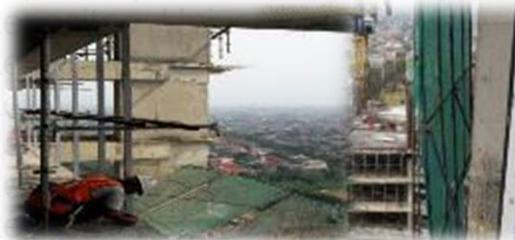
Gambar 4.82 Pemasangan *Safety Net*
