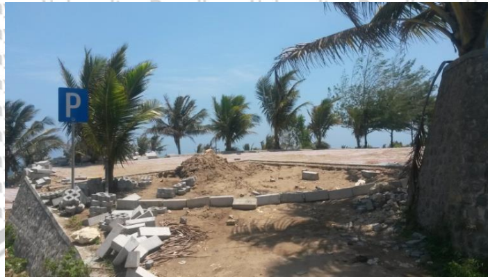
Gambar 3. 4 Perbaikan Area Parkir Pantai Klayar
