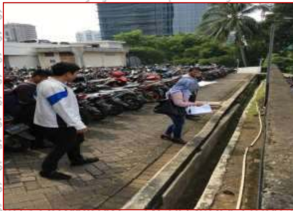
Gambar 3.2 Lokasi Studi Sisi Yang Berbatasan Dengan Lahan Parkir Areal Pengembangan (Saluran drainase internal yang menampung aliran dari depan lokasi studi ke arah kali grogol)
