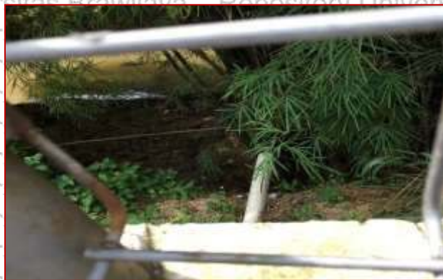
Gambar 3.3 Effluent Saluran Drainase Internal Menuju Kali Grogol
