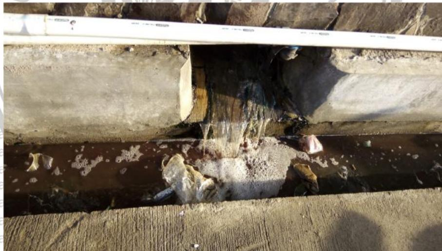
Gambar 16 Kondisi drainase area TPI (terdapat sampah plastik, potongan ikan, endapan, aliran tidak lancar)
