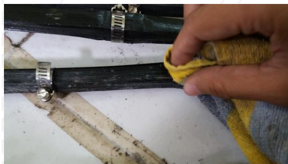
Gambar Tulangan bambu yang ditumbuhi jamur (kiri) dibersihkan dahulu sebelum ke tahap pelapisan Sikadur dan Pasir
