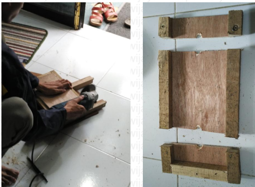
Gambar Pemotongan bekesting letak tulangan bambu (kiri) dan hasil pemotongan (kanan) pada bekesting benda Uji Pull Out
