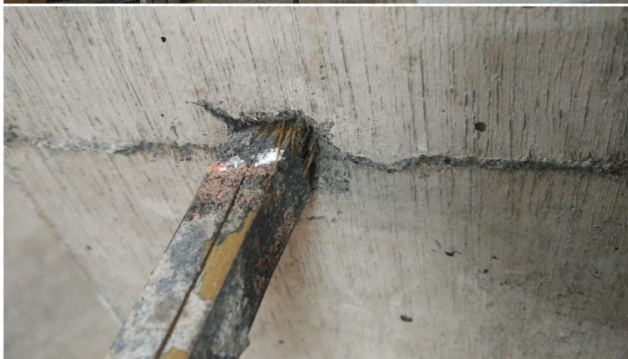
Gambar Keruntuhan Benda Uji Pull Out A 1 B 1 -2
