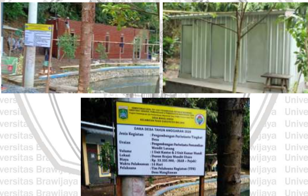
Gambar 4.6. Proses Pembangunan Fasilitas Wendit Lanang
