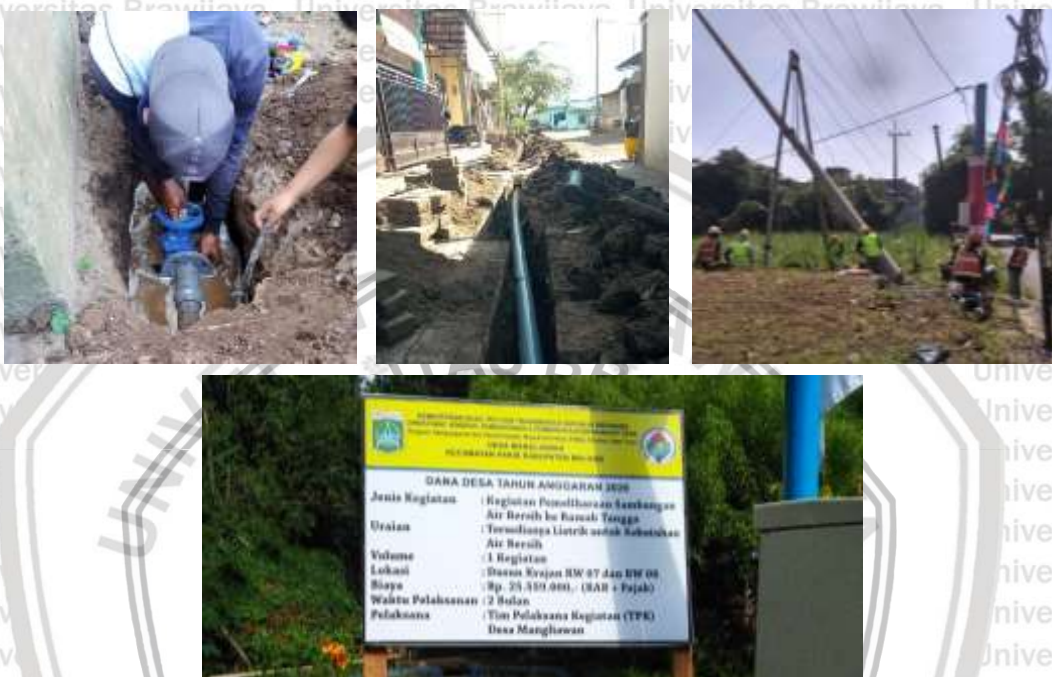
Gambar 4.7. Proses Pemasangan Listrik untuk Kebutuhan Air Bersih
