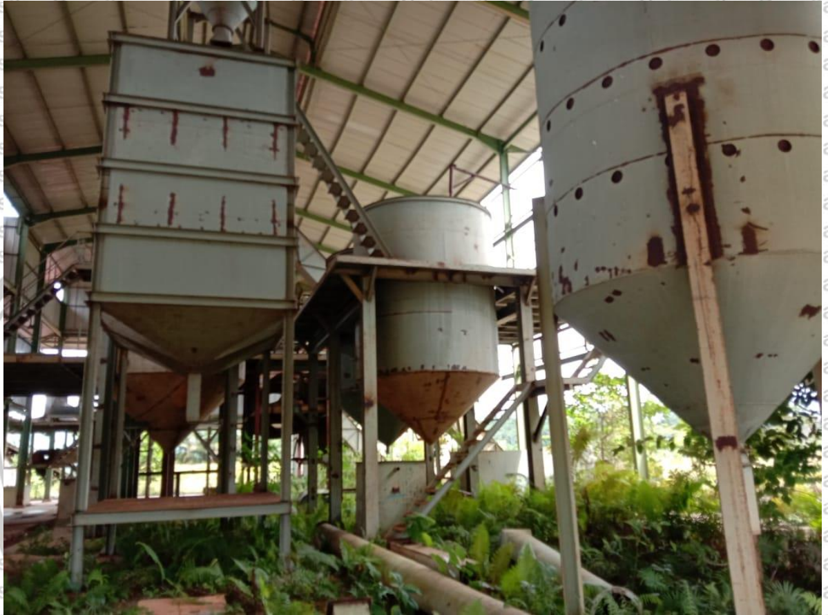
Foto-foto Pabrik Kelapa Sawit
