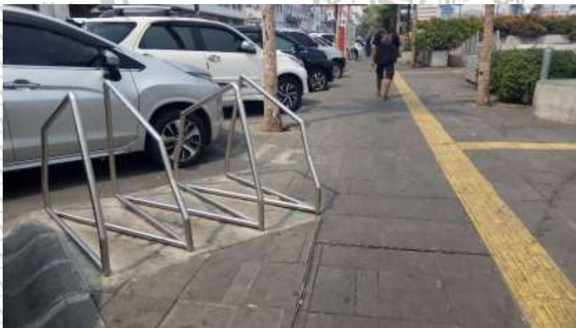
Gambar 4.51 kondisi fasilitas parkir untuk sepeda pada segmen 8
