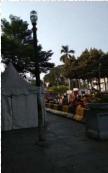
Gambar 4.39 Kondisi Lampu Penerangan di Segmen 1
