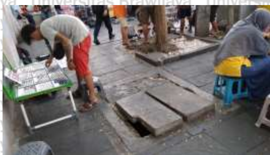
Gambar 4.37 Saluran Drainase Tertutup di Segmen 1 dan Segmen 4
