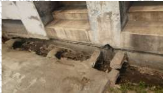
Gambar 4.38 Saluran Drainase Terbuka di Segmen 15
