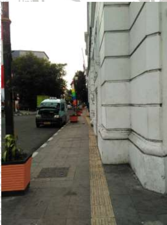
Gambar 4.55 kondisi insfrastruktur disabilitas pada segmen 17
