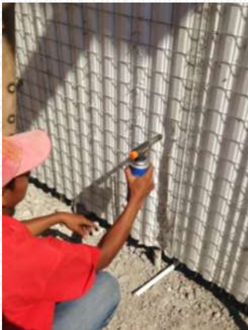
Gambar 4.15 Pelelehan EPS dengan menggunakan hot gun
