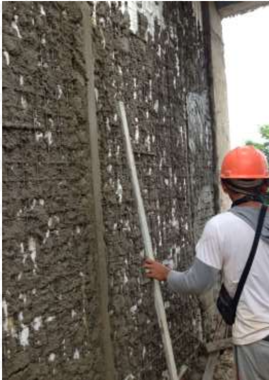
Gambar 7. Persiapan Pemlesteran Tahap 2
