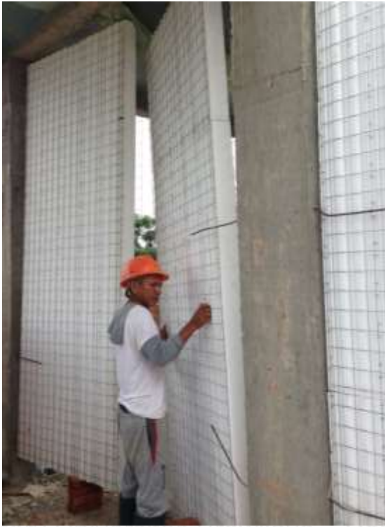
Gambar 4.8 Pemasangan Dinding Panel
