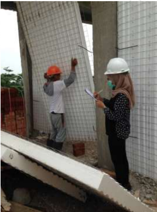
Gambar 3. Pemasangan Dinding Panel
