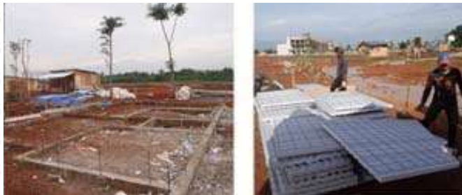
Gambar 2.9 Pemasangan Besi Stek
