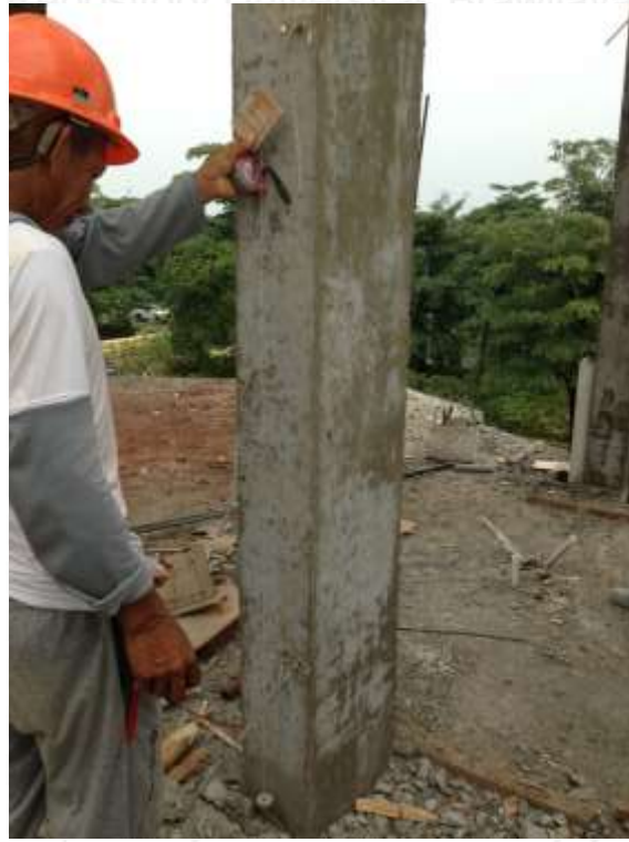
Gambar 2. Persiapan Pemasangan Dinding Panel
