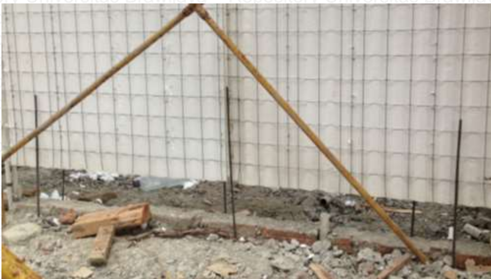
Gambar 4.4 Besi Stek yang Dipasang saat Pengecoran
