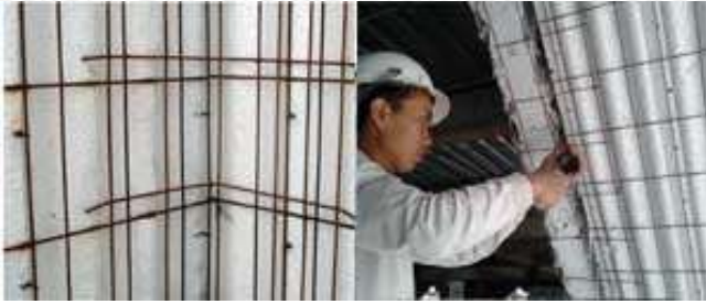
Gambar 2.12 Pemasangan Wiremesh Siku
