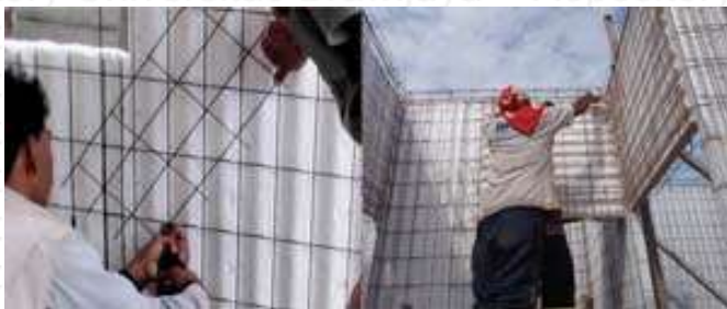
Gambar 2.11 Pemasangan Cross-Brace dan U-Mesh
