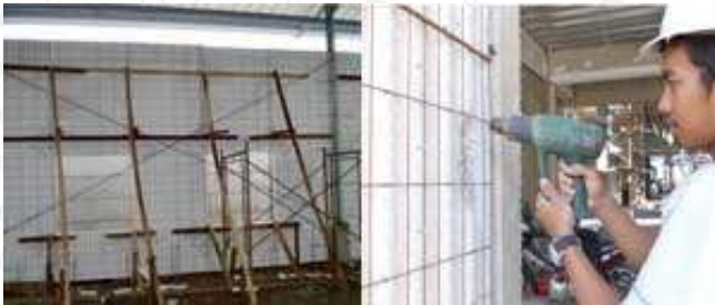
Gambar 2.13 Pemasangan Support dan Instalasi M/E
