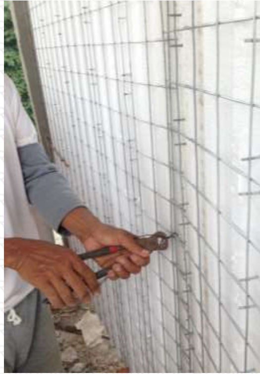
Gambar 4. Pemasangan Perkuatan Panel
