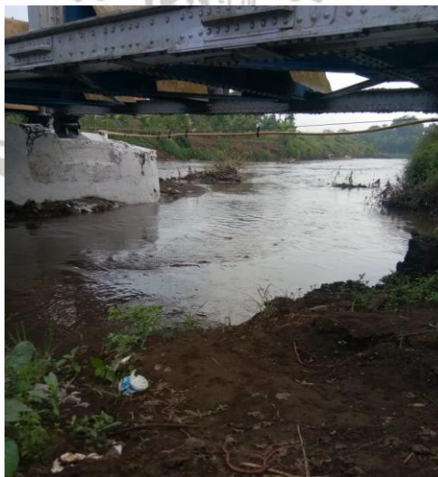
Gambar 21. Lokasi pengamatan stasiun 1 (Dokumentasi Pribadi, 2021)
