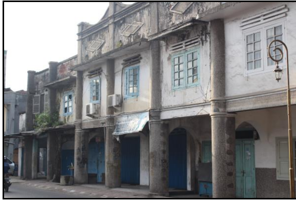
Gambar 4. 2 Bangunan kuno pada Jalan Niaga Sumber: Hasil Survei, 2016
