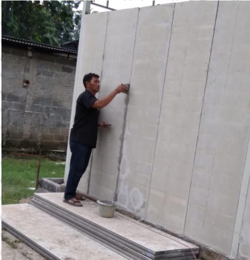
Gambar 2. 12 Dinding Panel Beton.
