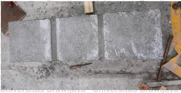
Gambar 6. Pelepasan bekisting setelah beton berumur 24 jam
