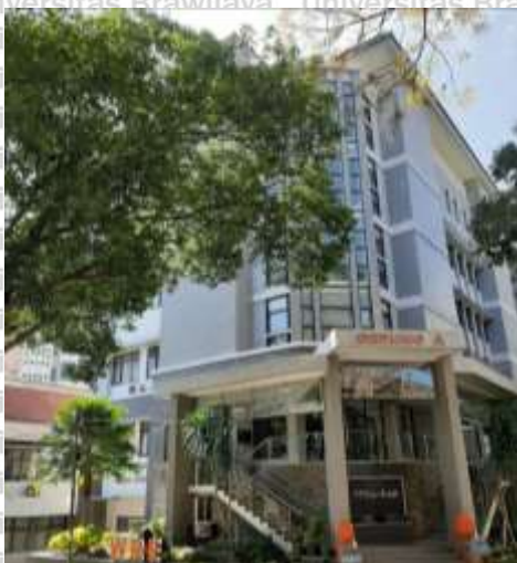
Tampak pintu masuk gedung
