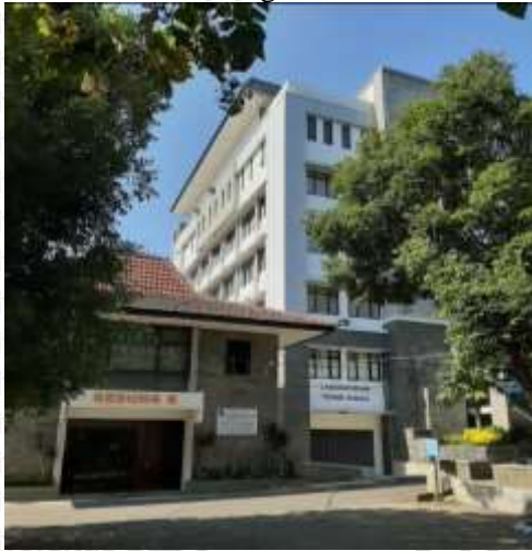
Tampak samping gedung, bangunan sekitar dan vegetasi
