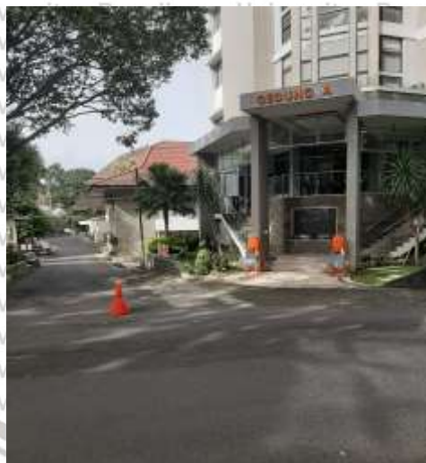
Tampak pintu masuk gedung
