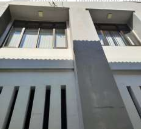
Pencahayaan pada bagian belakang gedung
