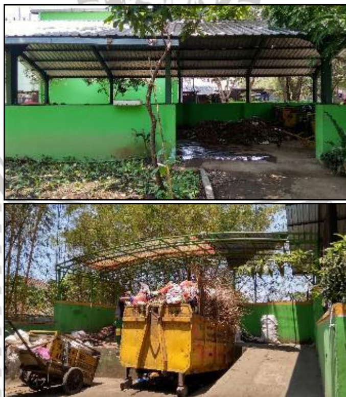
Gambar 4. 18 Kondisi TPS Kedungkandang Sumber: Survei Primer, 2019
