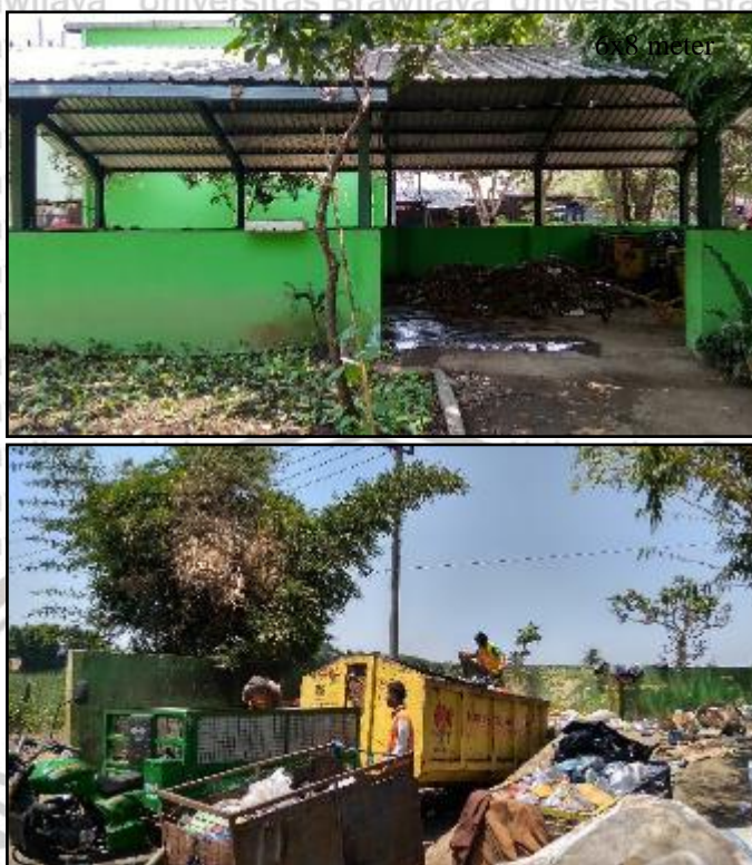
Gambar 4. 26 Kondisi TPS Arjowinangun Sumber: Survei Primer, 2019
