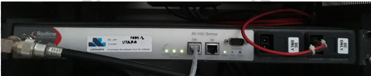
Gambar 4.4 IDU AN100U pada Base Station (BS)
