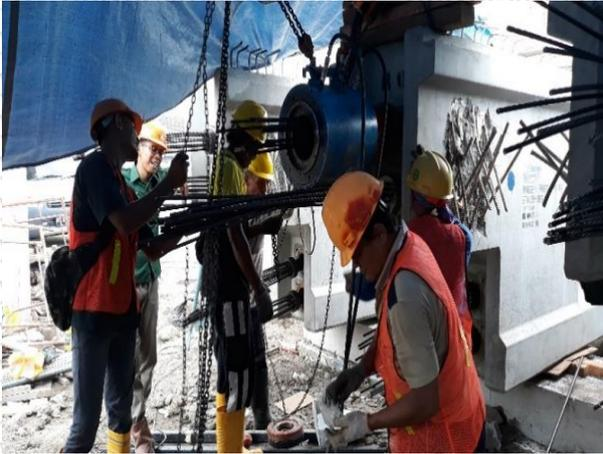
Gambar 2.3 Proses *stressing* pada balok beton prategang pasca tarik (Sumber: Munir, 2018)
