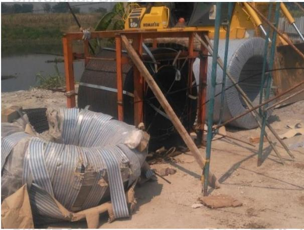
Gambar 2.4 *Strand* baja yang digunakan dalam *stressing* (Sumber: Munir, 2018)
