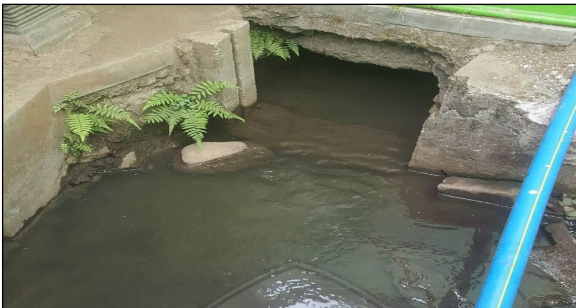
Gambar 3.7 Inlet Saluran Sumber : Dokumentasi Pribadi
