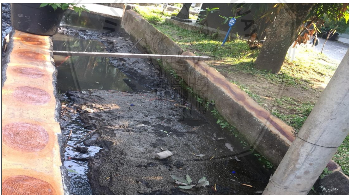
Gambar 3.8 Kondisi Saluran Sumber : Dokumentasi Pribadi
