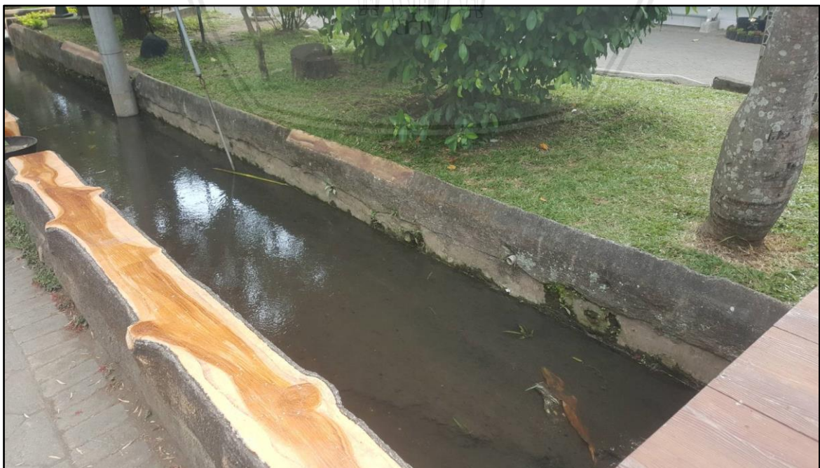
Gambar 4.1 Lokasi perencanaan IPAL dengan menggunakan metode wetland Sumber: Dokumentasi Pribadi, 2019
