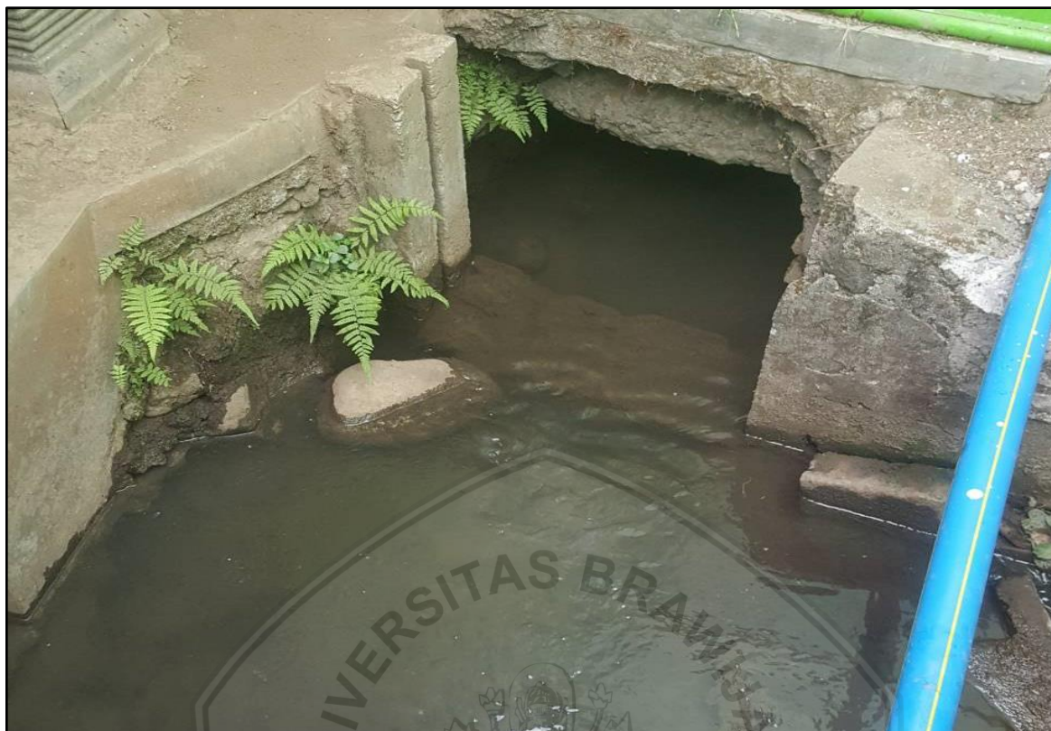
Gambar 4.5 Inlet Saluran Sumber : Dokumentasi Pribadi, 2019
